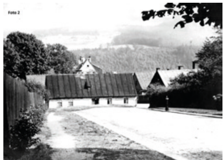
Falkenstein i.V., Blick auf den geraden Teil der Clara-Zetkin-Straße, gut zu sehen der Straßenverlauf rechts um die Holzbrunnenhäuser Nr. 11 vorn und Nr. 17 dahinter; rechts neben der Straße die Häuser Nr. 13 vorn und Nr. 15 dahinter (Bauer Kleditzsch). Die Häuserreihe Mitte hinten wurde 1922 bis 1927 gebaut und trägt die Hausnummern 24 – 34. Links oben befindet sich der Zaun vom Sportplatz des „TV 1840 Falkenstein“. Foto: etwa 1950, Sammlung Andreas Rößler
